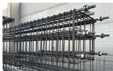
Tornillos largos en armazón de pilar.
