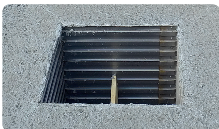
Fraguado del hormigón.
