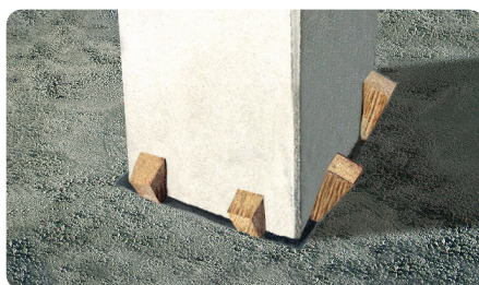
Colocación del pilar.
