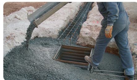
Relleno del espacio exterior del CUBIX.
