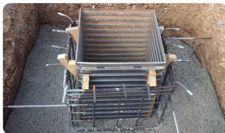
Colocación del CUBIX.
