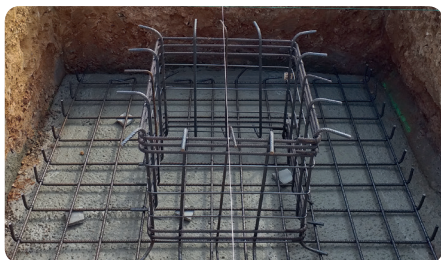
Preparación de foso.
