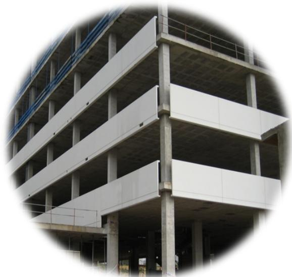
Sistema de sustentación de paneles para fachadas arquitectónicas. Capacidades portantes de 570 a 1.540 kg. Diseño compacto con regulación en las tres direcciones principales.
