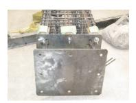
Plantilla o tape de final de molde para fijar los pies de pilar en posición correcta. También se fijan las barras del pie de pilar a la armadura principal del pilar.
