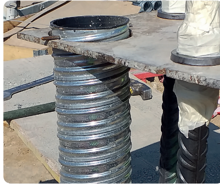
Detalle vaina con tapa - tornillo - plantilla.
