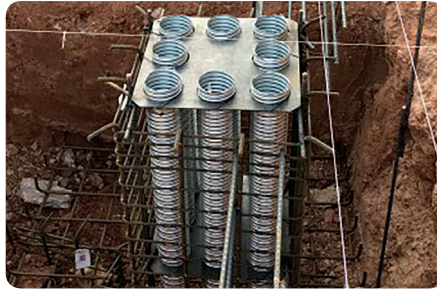
Fijación de la armadura.
