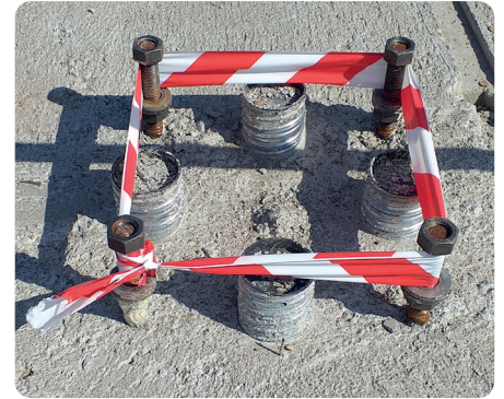
Rellenado de hormigón.
