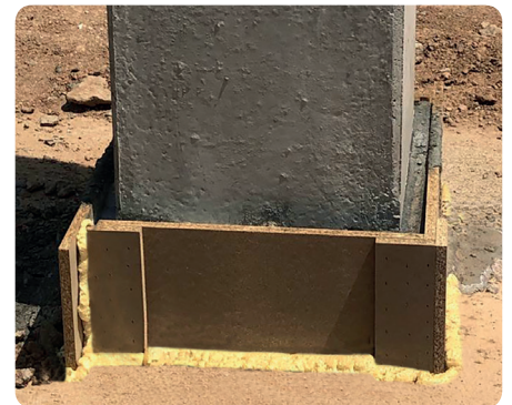
Fraguado de relleno de la junta.
