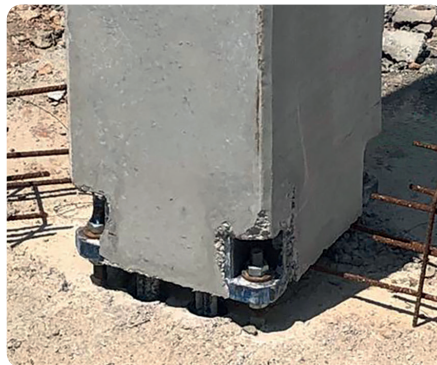
Pilar situado en posición y atornillado.
