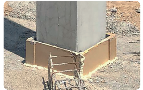
Preparación para el grouteado de las vainas.
