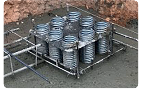
Rellenado de hormigón.
