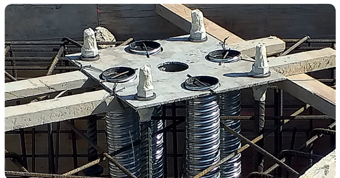
Posicionamiento en obra preparada para encofrado.
