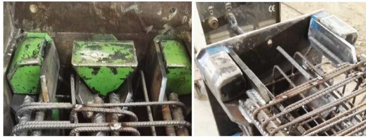
Figura 9.1 Cajas de instalación para fijación en tape molde (central y esquinera)
