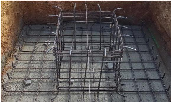
1. **Preparación** del pozo de cimentación con el armado donde se alojará el CUBIX
