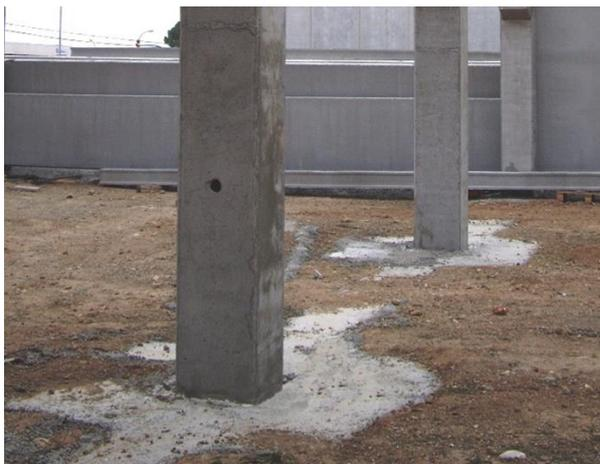
6. **Relleno de la junta** entre el CUBIX i el pilar. Se recomienda el uso de mortero sin retracción tipo GROUT.
