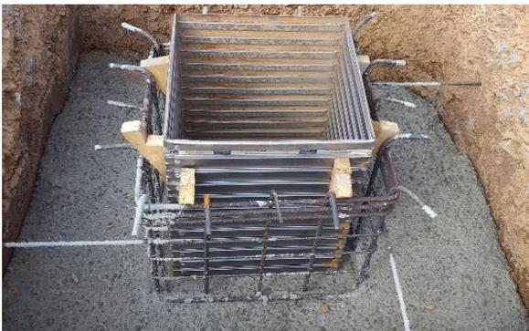
2. **Colocación del CUBIX** dentro de la malla de cimentación junto con cuñas para evitar su desplazamiento durante el hormigonado.
