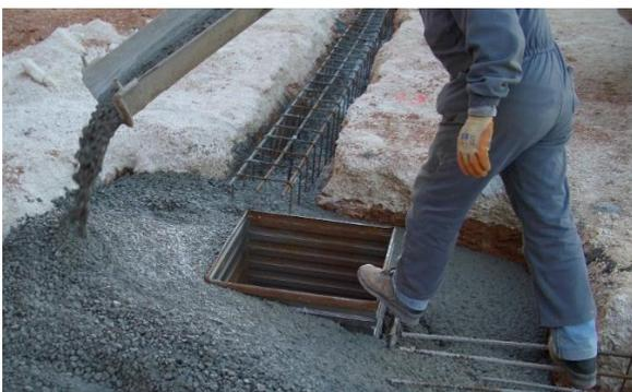
3. **Relleno de la zapata** de cimentación hasta la altura del CUBIX. Comprobar que durante el hormigonado no se desplace el cáliz.
