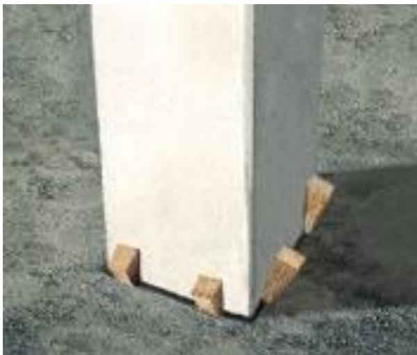
5. **Inserción del pilar** en el CUBIX i fijación con cuñas garantizando su verticalidad.
