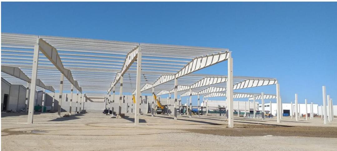
**Figura 6.1 Pilares colocados mediante el sistema CUBIX**
