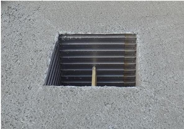
4. Se deja **fraguar** el hormigón hasta que éste adquiera una resistencia adecuada.
