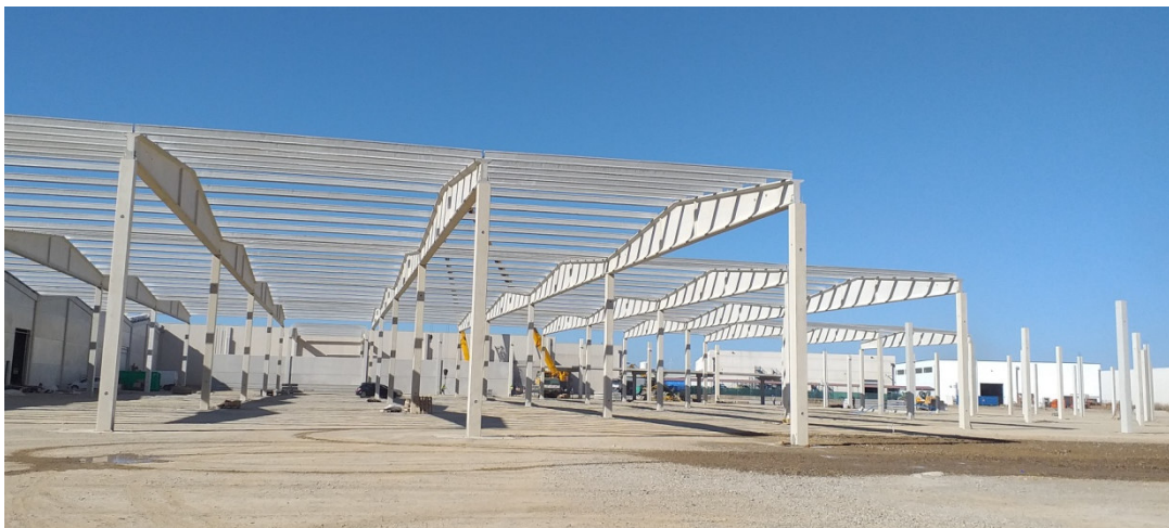
Figura 6.1 Pilares colocados mediante el sistema CUBIX
