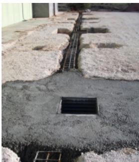
2. Hormigonar la cimentación hasta la altura del CUBIX.
