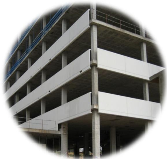
Sistema de sustentación de paneles para fachadas arquitectónicas. Capacidades portantes de 932 a 3.755 kg. Diseño compacto con regulación en las tres direcciones principales.
