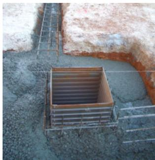
1. Colocación del CUBIX en el armado.
