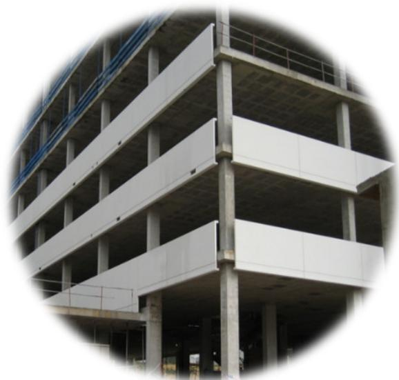
Sistema de sustentación de paneles para fachadas arquitectónicas. Capacidades portantes de 840 a 3.011 kg. Diseño compacto con regulación en las tres direcciones principales.
