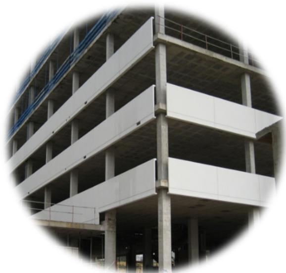
Sistema de sustentación de paneles para fachadas arquitectónicas. Capacidades portantes de 1.242 a 3.457 kg. Diseño compacto con regulación en las tres direcciones principales.
