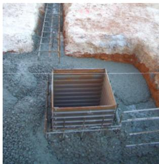
1. Colocación del CUBIX en el armado.
