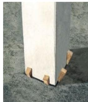
3. Colocar el pilar en la cimentación y rellenar la holgura del material de llenado.
