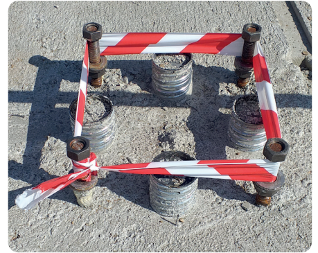
Rellenado de hormigón.
