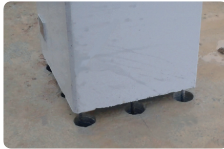
Varillas del pilar introducidas en las vainas.
