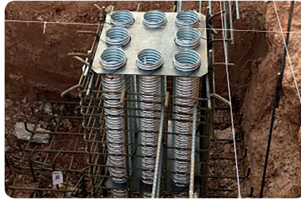
Fijación de la armadura.
