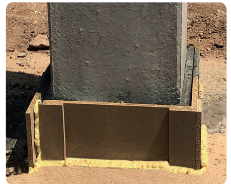
Fraguado de relleno de la junta.
