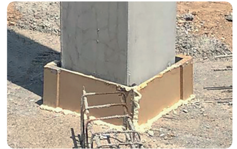
Preparación para el grouteado de las vainas.
