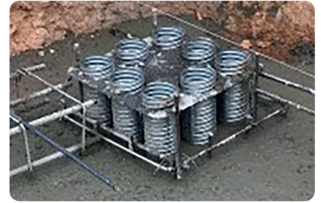
Rellenado de hormigón.
