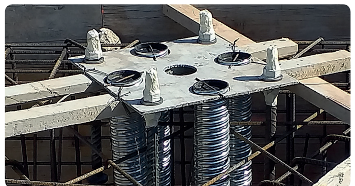
Posicionamiento en obra preparada para encofrado.
