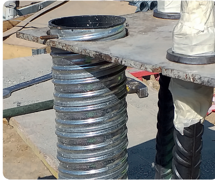
Detalle vaina con tapa - tornillo - plantilla.
